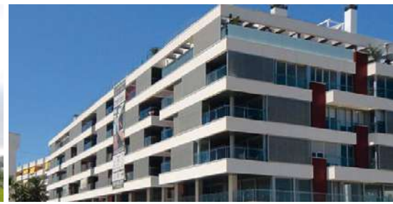
Edificio Ikebana. IBIZA
